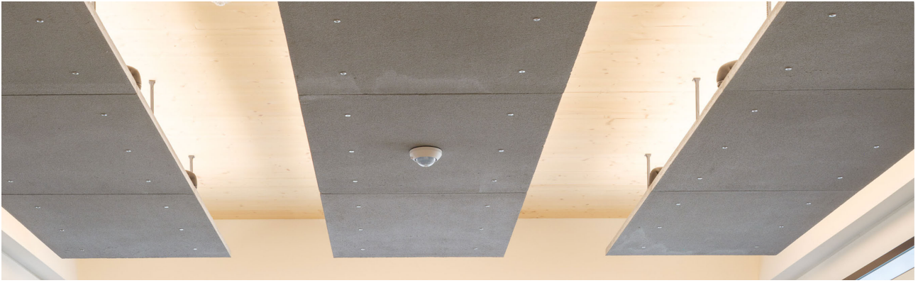
5: Leichte Farbunterschiede/Schattierungen auf einzelnen Paneelen
