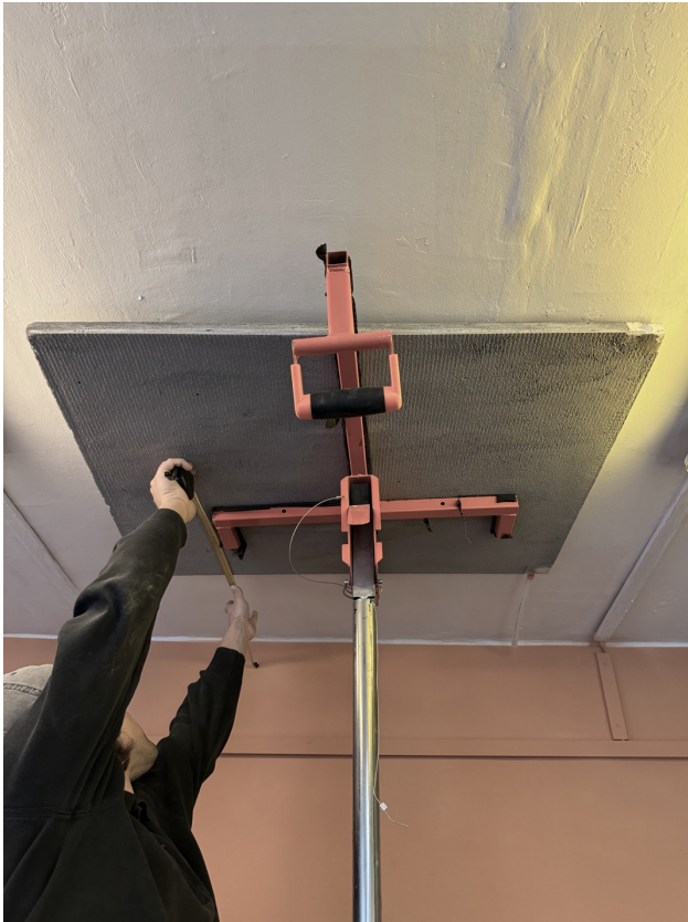
(a) Einrichten der Platte mit Plattenheber
