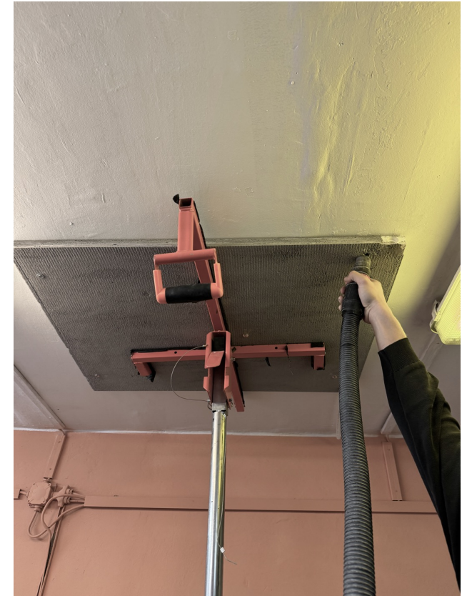
(c) Reinigen der Löcher mit Staubsauger
