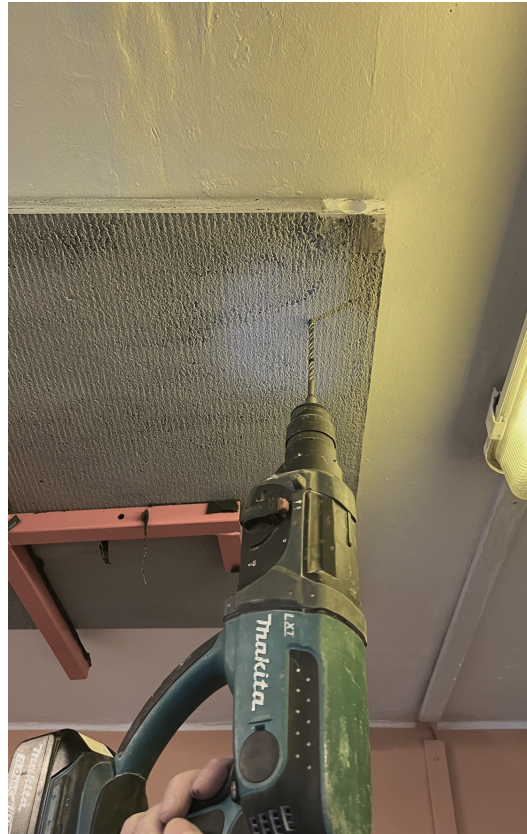
(b) Bohren von Platte (ohne Schlag) und Betondecke mit Schlagbohrmaschine
